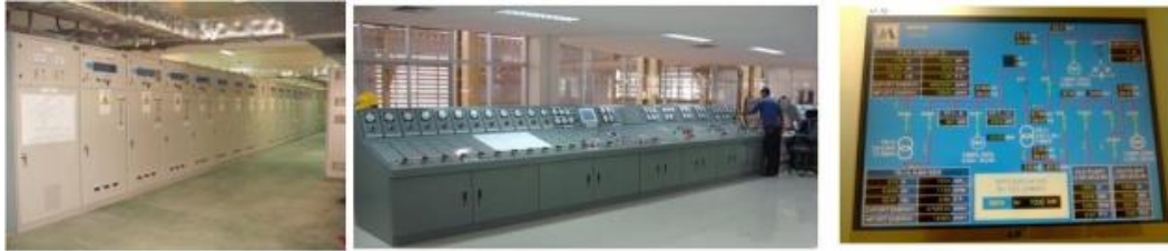
ภาพแสดงระบบ Switchgear Panel พร้อมระบบ PLC และการสื่อสารกับระบบรายงานผลจากคอมพิวเตอร์
