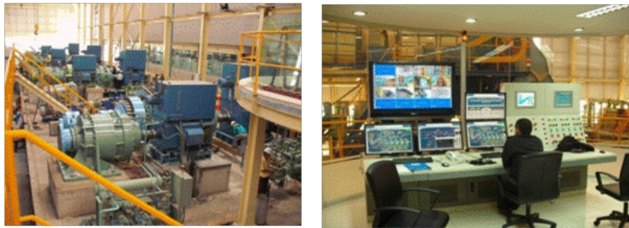
ภาพแสดงระบบควบคุมความเร็วพร้อม Motor ขนาด 1,500 kW. และ 630 kW. พร้อมระบบ PLC และการสื่อสารกับระบบรายงานผลจากคอมพิวเตอร์
